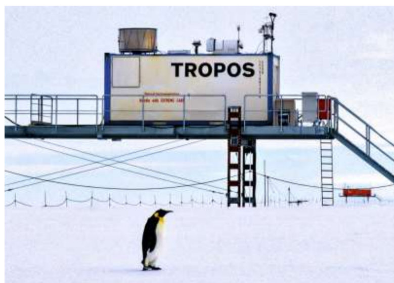
Der Oceanet-Container voller Messtechnik ist die tägliche Anlaufstelle für Martin Radenz – und für tierische Zaungäste.
